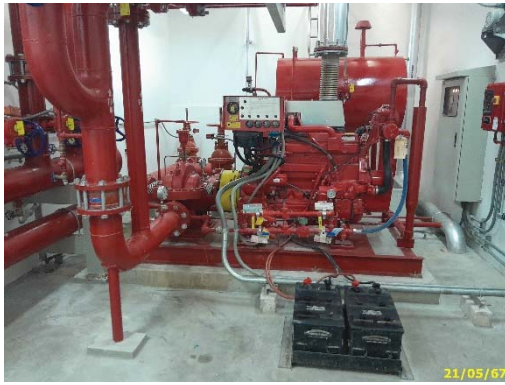
เครื่องปั้มน้ำดับเพลิง ชั้นห้องเครื่องชั้นใต้ดิน อาคาร X
