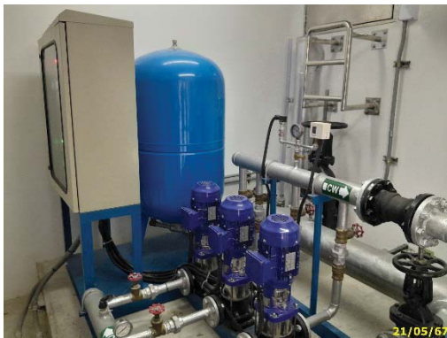
Booster Pump อาคาร X
